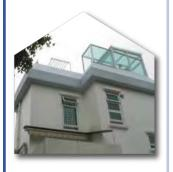
以鋼筋混凝土、磚石或其他材料建造及圍封的天台 搭建物,其覆蓋面積不多於主體建築物有蓋面積的 50%。
