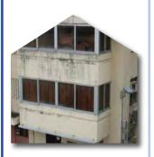
以鋼材、鋁質構件、金屬板或玻璃搭建的圍封式 露台。
