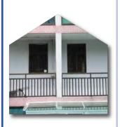
豎設於兩幢相連的新界豁免管制屋宇露台之間的間隔牆,而牆身超過150毫米厚。
