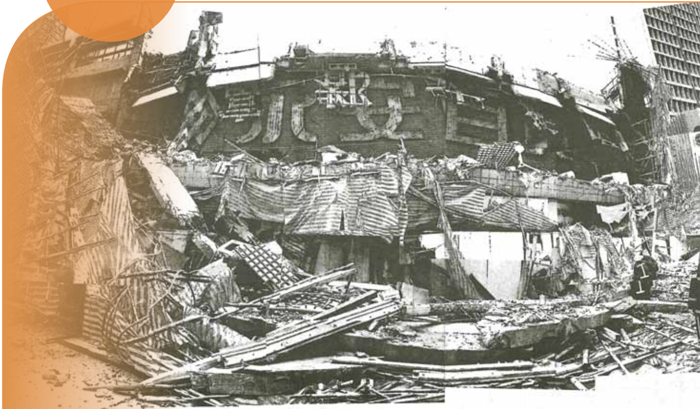
永安大廈在1994年拆卸期間倒塌
