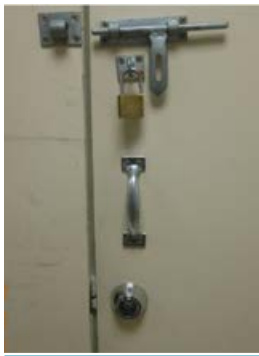
在出口門上安裝須使用鑰匙 開啟的鎖扣裝置 Installation of key-operated locking devices on exit doors
