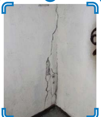
出現裂縫 Presence of Cracks
