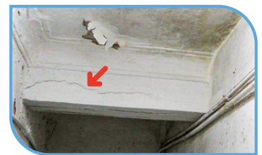
沿混凝土內鋼筋產生的縱向裂縫
