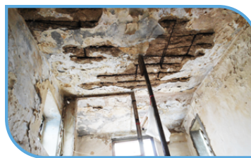
滲水導致混凝土剝落及鋼筋外露
