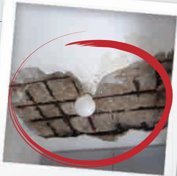
在天花的混凝土剝落
