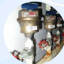
供水喉管測試
