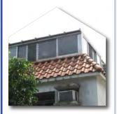
以鋼筋混凝土、磚石或其他材料建造及圍封的天台搭建物,其覆蓋面積多於主體建築物有蓋面積的50%。
