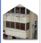
以鋼材、鋁質構件、金屬板或玻璃搭建的圍封式 露台。
