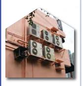
由主體建築物外牆伸建用以支承冷氣機的金屬架 (必須附防止滴水設計)及冷氣機輕質篷蓋,屬可 常設的小型環保及適意設施除外。
