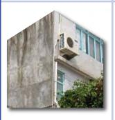
用以支承冷氣機的金屬架(必須具有防止滴水設計)、 分體式冷氣組件及冷氣機輕質篷蓋
