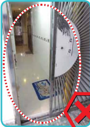
樓宇單位原有入口的防火門被拆除，令各分間單位之間的走廊直接通往出口樓梯/防煙門廊
