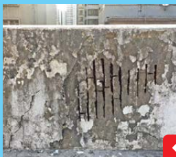
裂痕 / 鋼筋外露
