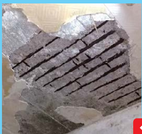
石屎剝落 / 鋼筋外露
