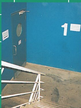
樓梯及消防門
