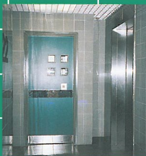
消防員升降機門廊
