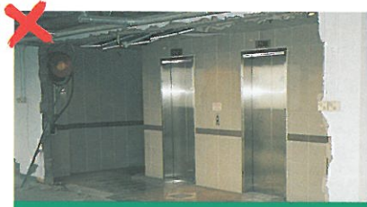
拆去消防員升降機門廊
