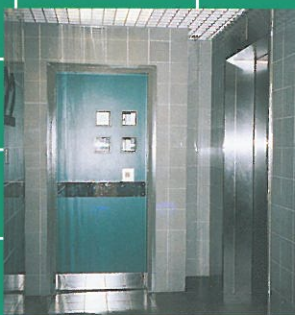
消防員升降機門廊
