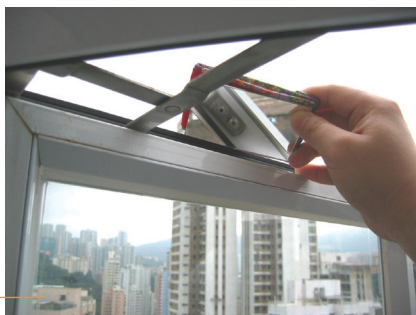
檢查窗扇頂部及底部的鉸槽
