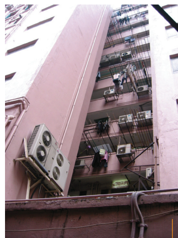
從樓宇外牆伸出的冷氣機支撐框架
