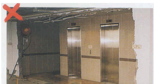
拆去消防員升降機門廊
