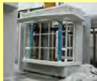
非結構預製外牆
