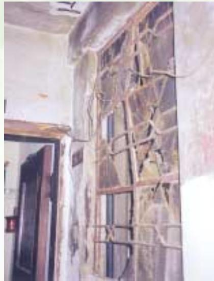
安裝鋁窗涉及不同的組件如柳釘、螺絲、窗鉸及錨釘的嵌合，這些組件均容易損毀，需定期維修及保養。有摩擦力的開關窗鉸(即一般鋁窗的四竿鉸)是窗戶的精細部份，需要經常留意，避免塵埃積聚，妨礙滑行。如果有需要時，可加上少許潤滑劑以減低移動部份的摩擦力。但加上的潤滑劑不可過量，否則摩擦力會完全消失，移動部份便無法固定，容易發生意外。若缺乏所需的維
