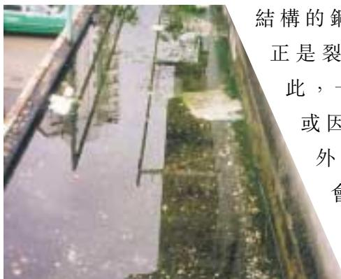
結構的鋼筋通常放近頂部，而該處正是裂縫經常先出現的地方，因此，一旦頂部防水層厚度不足，或因裂縫而撕裂，水便容易從外滲入，令鋼筋銹蝕。銹蝕會減少鋼筋的有效橫切面面積，減低其負荷能力，引發突然倒塌的意外。
