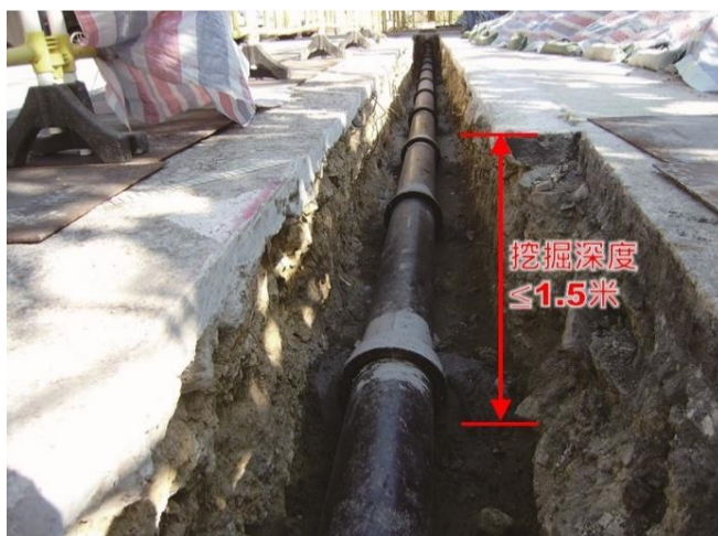
第 2.28、2.36、 加建、改動、修葺或拆除 2.29 項 地下排水渠
