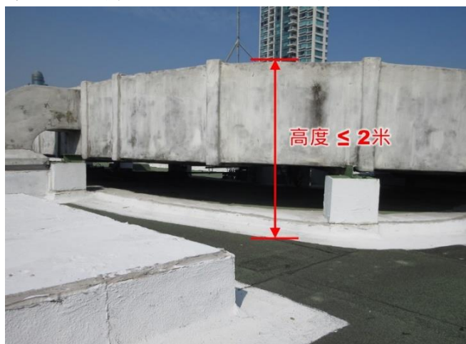
第 3.2 項 拆除屋頂上的通風管道或相關支架
