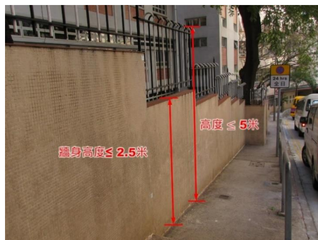
第 2.57 項 於地面上的實心圍牆頂部豎設金屬欄杆
