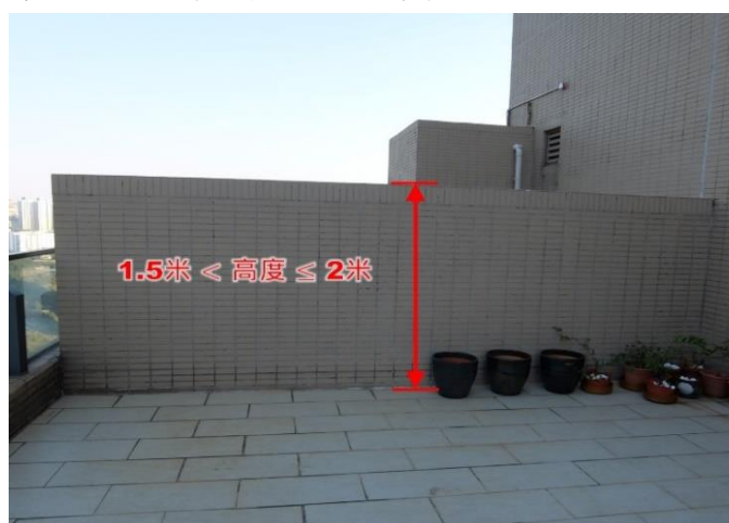
第 2.61 項 修葺屋頂上的實心圍牆
