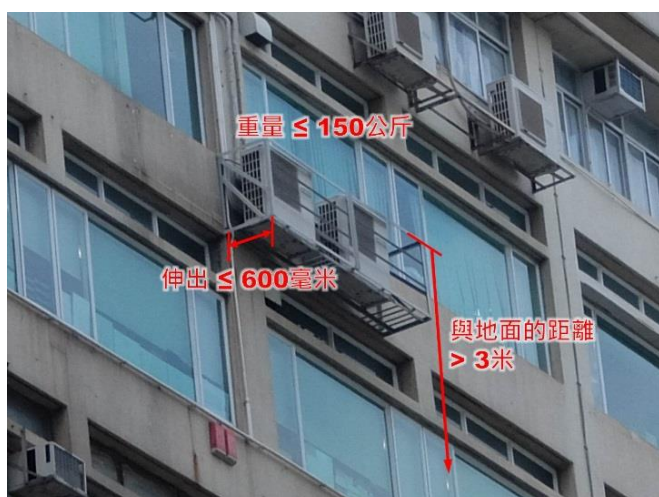
第 2.49 項 豎設或改動屋宇裝備裝置的承托支架
