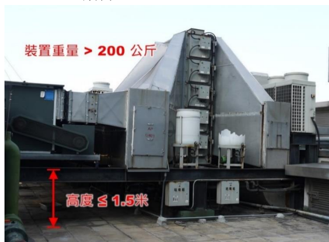
第 1.50 項 豎設或改動屋宇裝備裝置的支承構築物
