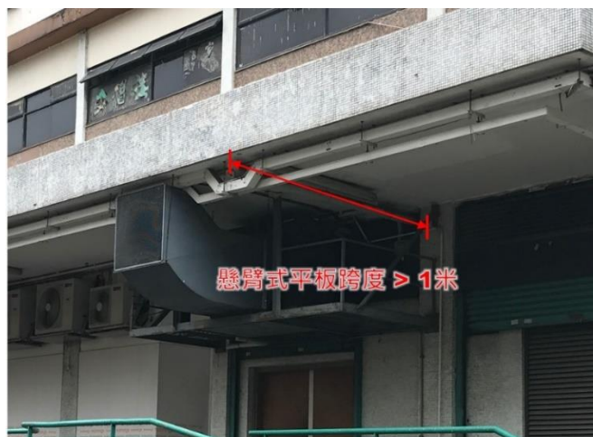
第 1.5 項 拆除位於懸臂式平板下的通風管道或相關的承托支架
