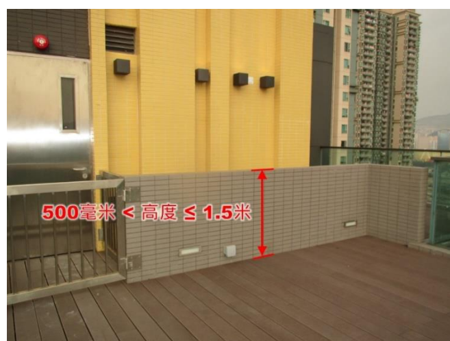
第 3.64 項 拆除屋頂上的實心圍牆
