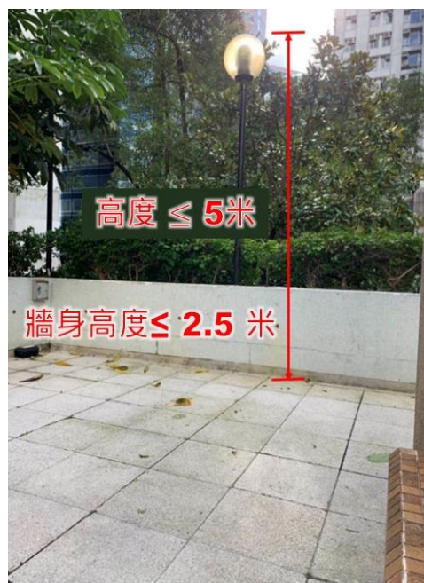
第 2.57 項 於地面上的實心圍牆豎設支柱
