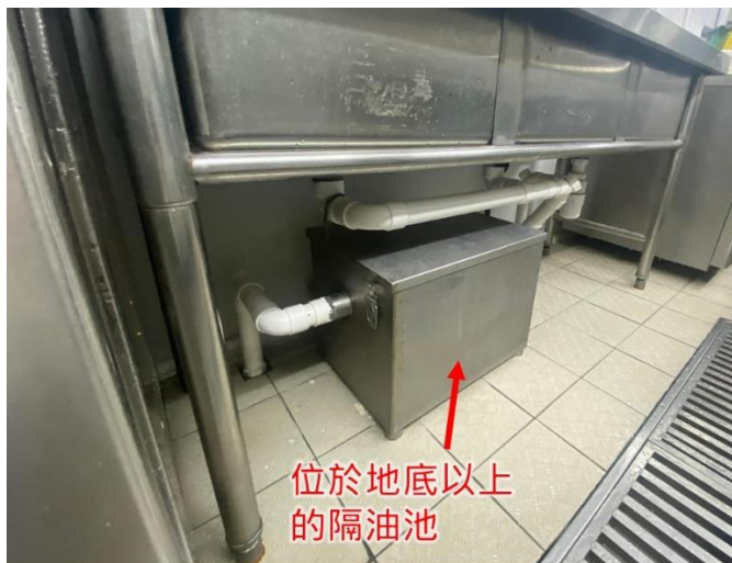
第 2.30 或 3.23 項 豎設、修葺、改動或拆除地底以上的隔油池
