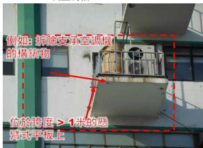
第 1.5 項 拆除屋宇裝備裝置的支承構築物或金屬箱
