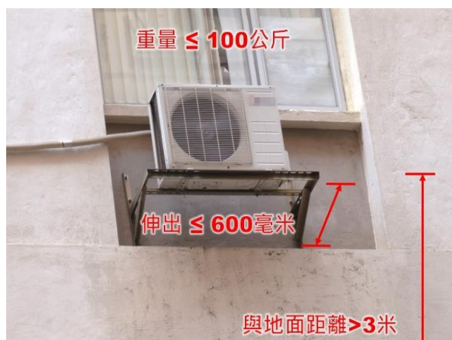
第 3.27 項 豎設、改動或拆除屋宇裝備裝置的承托支架
