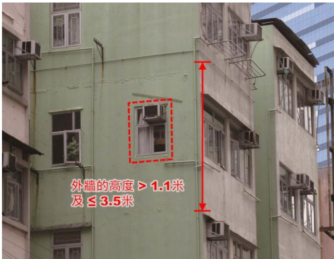
第 1.15 項 豎設、改動或拆除鋼筋混凝土外牆
