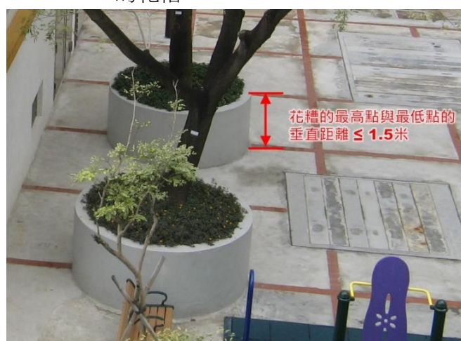
第 2.52 項 豎設、改動、修葺或拆除地面上的花槽
