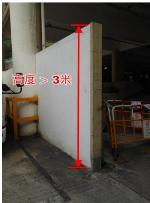
第 1.9 項 拆除地面上的實心圍牆
