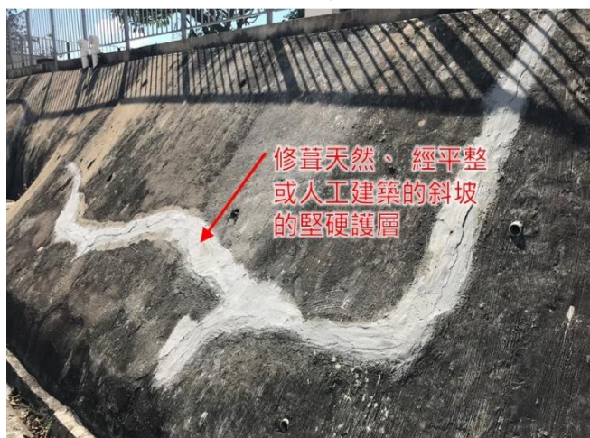
第 3.53 項 修葺天然、經平整或人工建築的斜坡的堅硬護層
