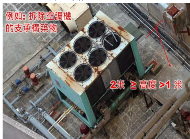
第 3.2 項 拆除屋宇裝備裝置的支承構築物或金屬箱
