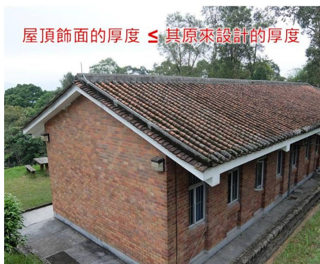
第 2.34 項 鋪設、修葺或拆除屋頂飾面
