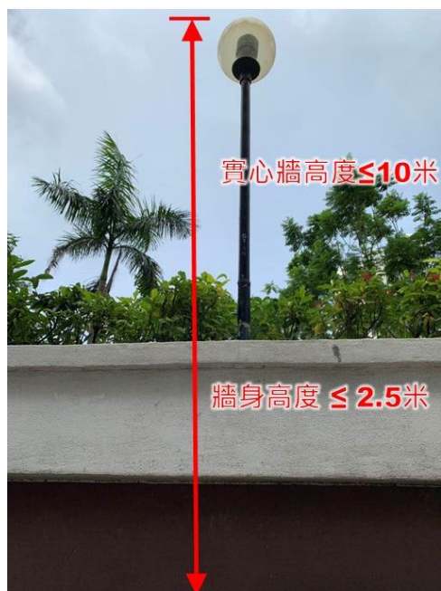
第 1.59 項 於地面上的實心圍牆豎設支柱
