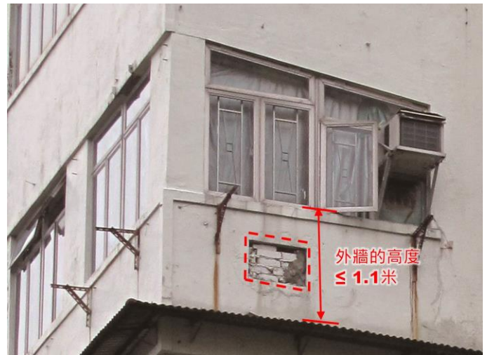
第 3.11 項 豎設、改動或拆除用磚建造的非承重外牆
