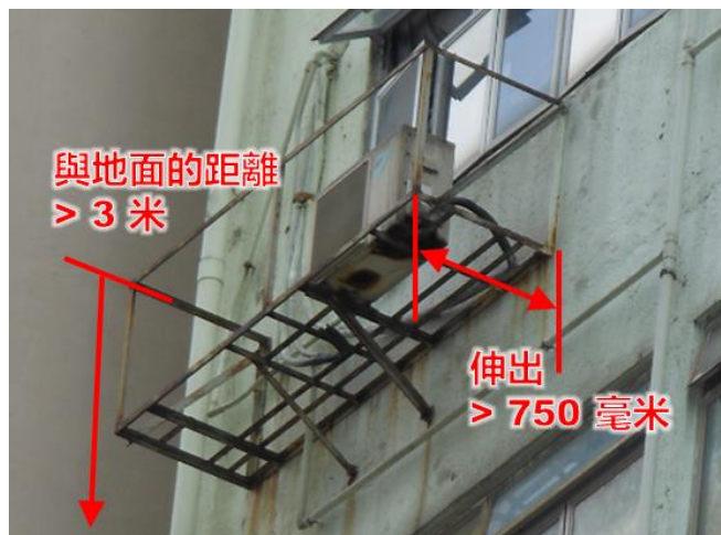
第 3.26 項 拆除外牆的承托支架
