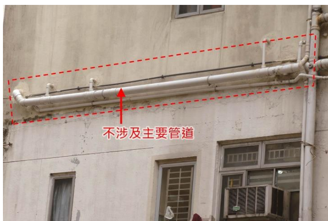
第 3.23 項 豎設、修葺、改動或拆除地底以上的排水渠
