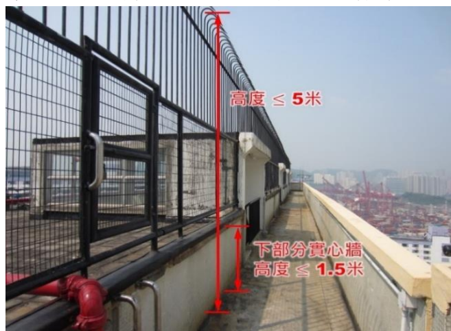
第 2.65 項 拆除屋頂上的網欄／金屬欄杆
