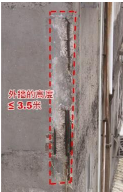
第 2.15 項 修葺鋼筋混凝土外牆
