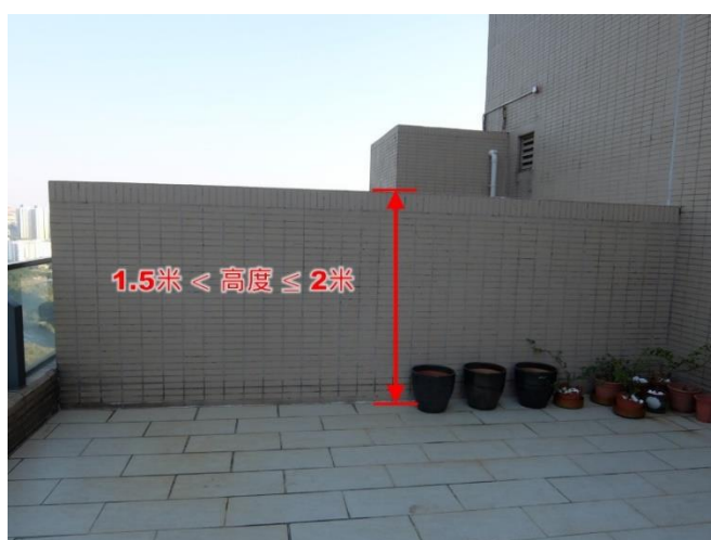
第 2.64 項 拆除屋頂上的實心圍牆
