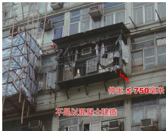
第 3.26 項 拆除自外牆伸出的架
