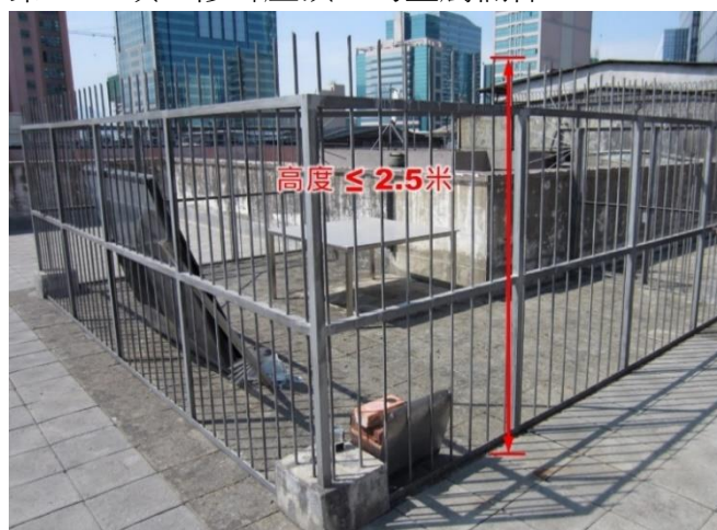
第 3.62 項 修葺屋頂上的金屬欄杆
