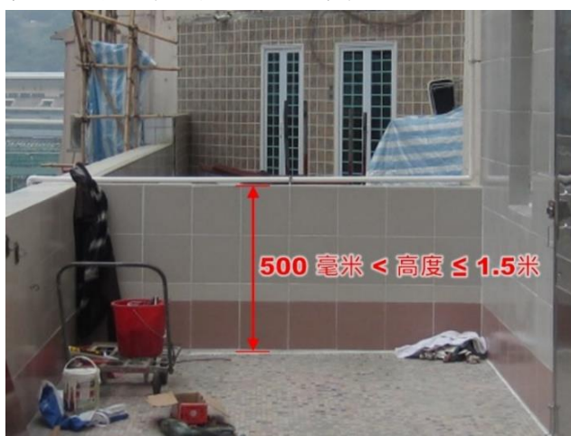
第 3.61 項 修葺屋頂上的實心圍牆
