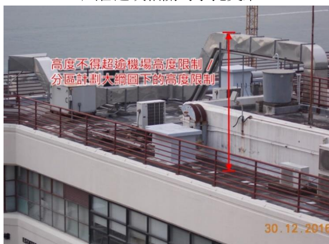
第 1.47 項 豎設或改動屋頂上的室外金屬通風管道或相關的承托支架
