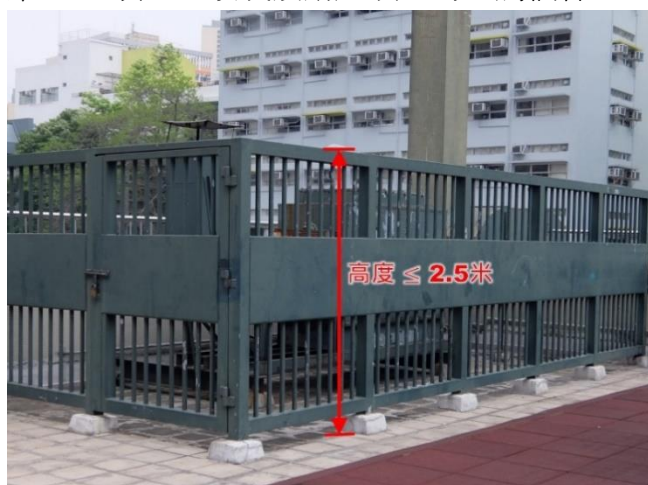
第 2.56 項 豎設或改動屋頂上的金屬欄杆
