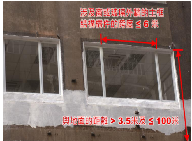
第 2.8 項 建造、改動、修葺或更換窗或玻璃外牆
