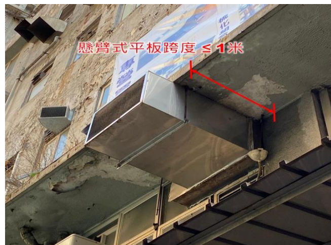
第 2.2 項 拆除位於懸臂式平板下的通風管道或相關的承托支架
