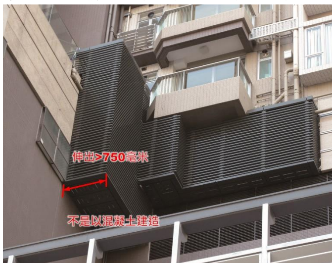
第 2.31 項 拆除自外牆伸出的建築上的伸出物
