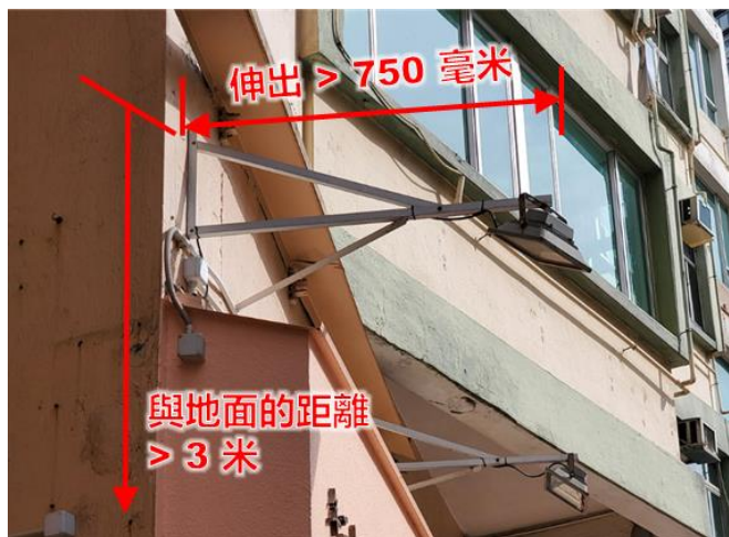
第 2.31 項 拆除外牆的承托支架
