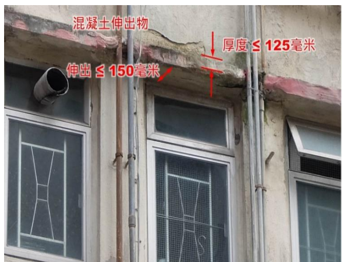
第 2.17 項 修葺結構構件
