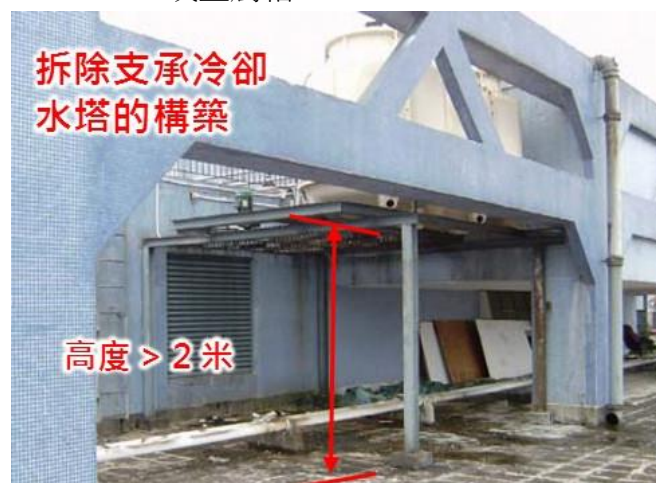
第 2.2 項 拆除屋宇裝備裝置的支承構築物或金屬箱
