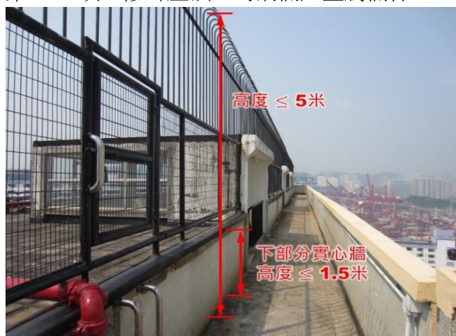
第 2.62 項 修葺屋頂上的網欄／金屬欄杆
