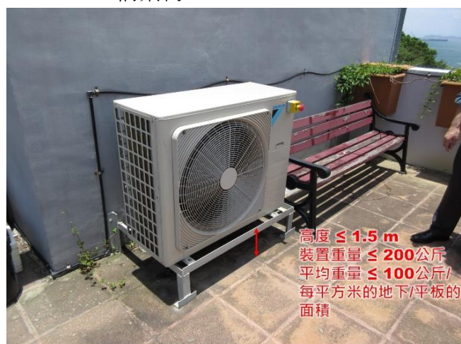
第 3.50 項 豎設或改動屋宇裝備裝置的支承構築物
