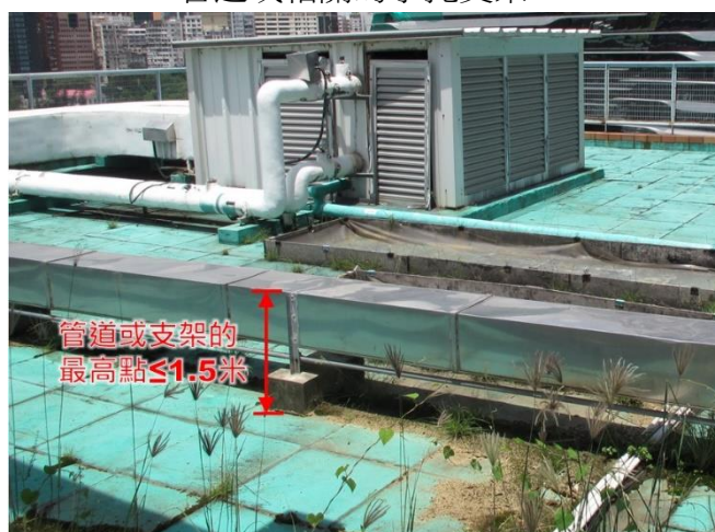
第 3.47 項 豎設或改動屋頂上的室外金屬通風管道或相關的承托支架
