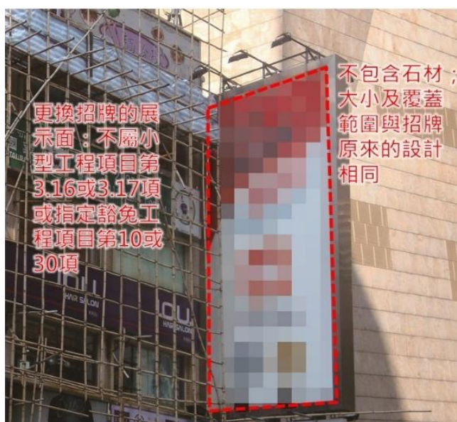
第 2.68 項 安裝、改動、更換或拆除招牌的展示面
