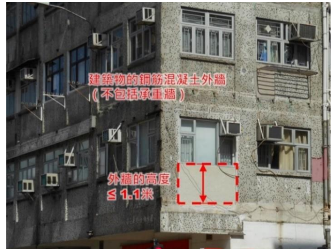
第 2.13 項 豎設、改動或拆除鋼筋混凝土外牆
