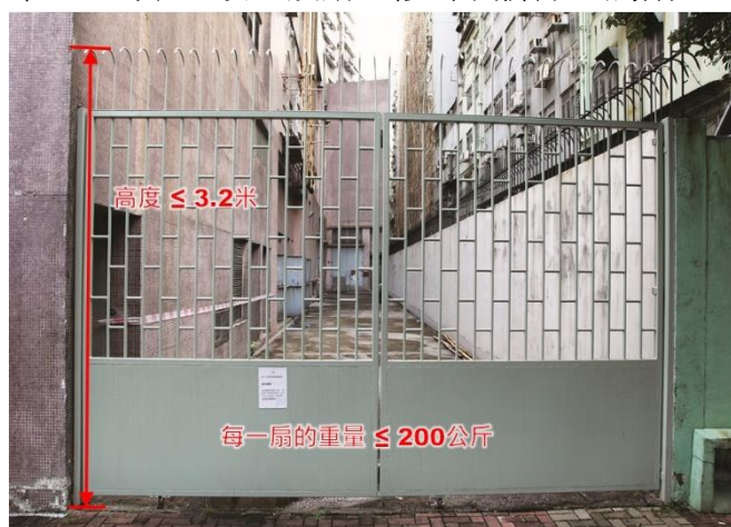
第 3.13 項 豎設、改動、修葺或拆除金屬閘
