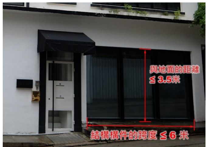
第 3.6 項 建造、改動、修葺或更換窗或玻璃外牆
