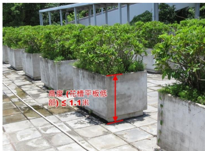
第 3.52 項 修葺或拆除屋頂上的花槽
