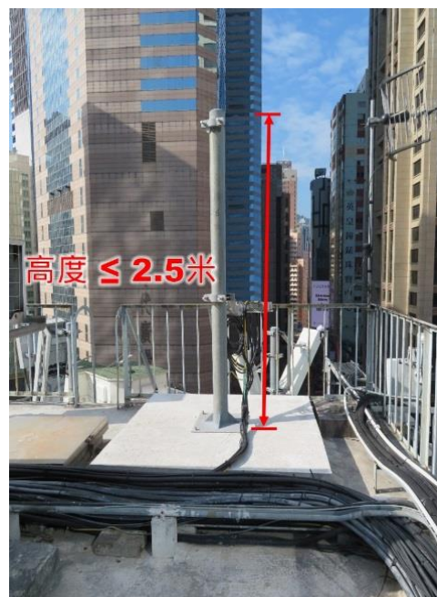
第 3.60 項 修葺屋頂上的支柱
