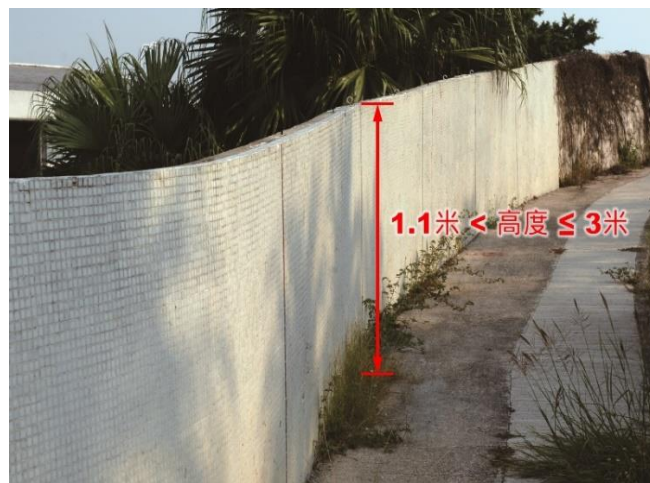
第 3.4 項 拆除地面上的實心圍牆
