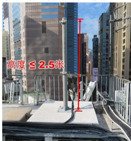
第 3.63 項 拆除屋頂上的支柱
