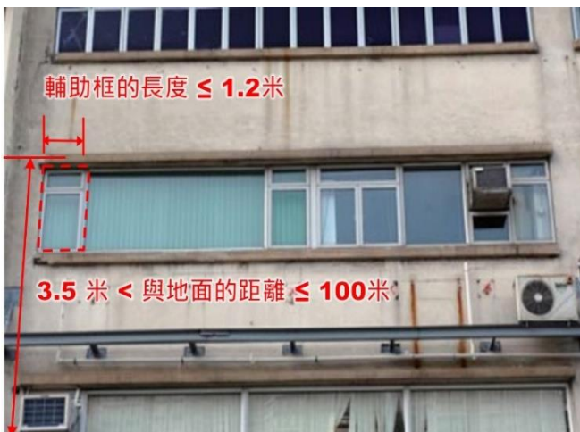
第 3.6 項 建造、改動、修葺或更換窗或玻璃外牆
