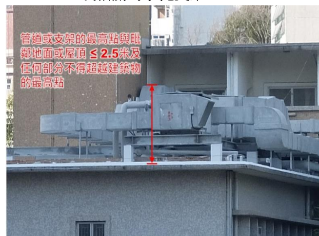
第 2.47 項 豎設或改動屋頂上的室外金屬通風管道或相關的承托支架
