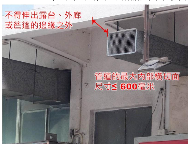
第 3.48 項 豎設或改動懸掛於露台底部之下的室外金屬通風管道或相關的承托支架
