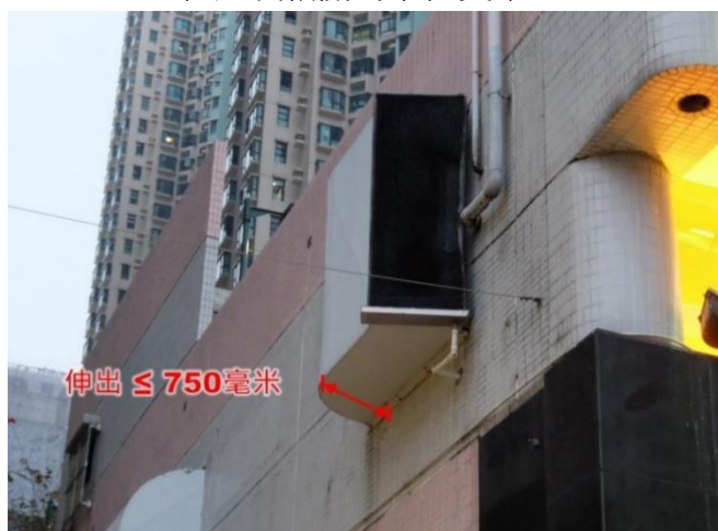
第 1.47 項 豎設或改動外牆的室外金屬通風管道或相關的承托支架
