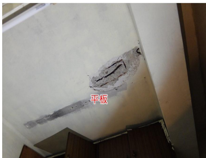
第 2.17 項 修葺結構構件
