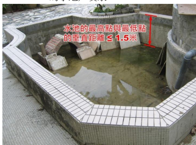
第 2.52 項 豎設、改動、修葺或拆除地面上的水池／噴泉
