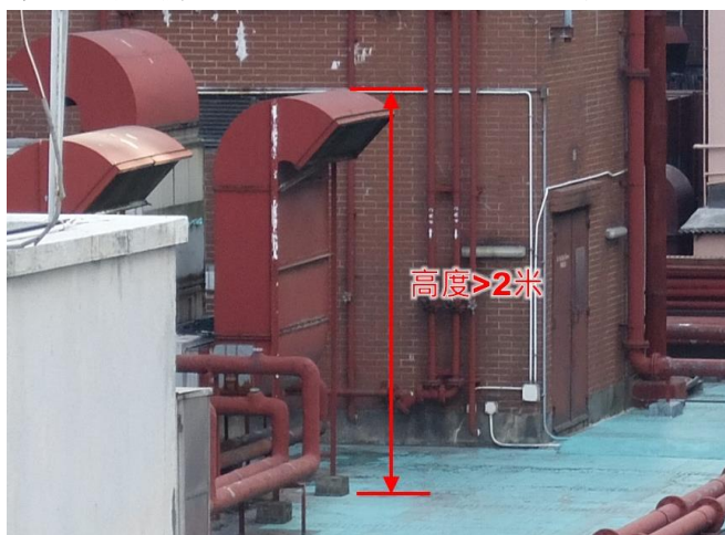
第 2.2 項 拆除屋頂上的通風管道或相關支架
