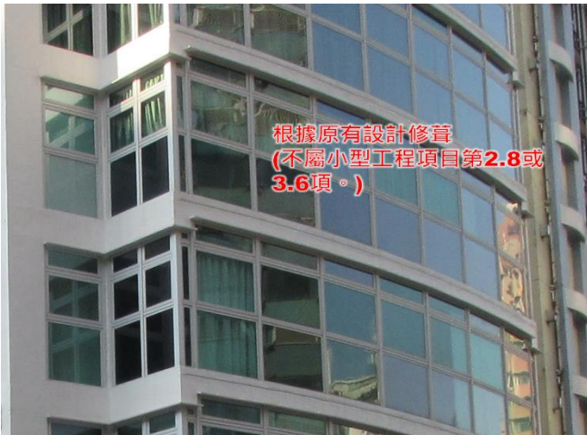
第 3.6 項 建造、改動、修葺或更換窗或玻璃外牆
