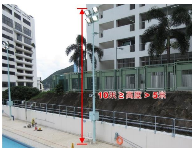
第 2.59 項 修葺地面上的室外支柱
