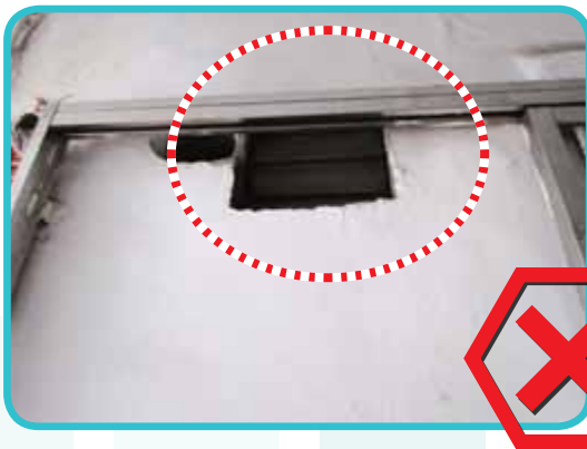
在分間單位與出口樓梯/防煙門廊間的牆壁開鑿通氣口。
