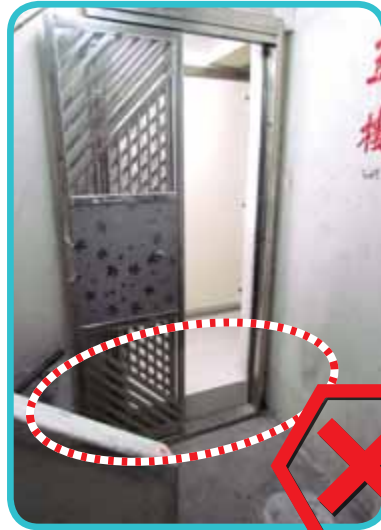
鋪設實心地台令致過度加厚樓板
