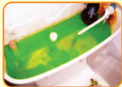
你也可按照下圖所示的步驟，使用色水偵測地台去水器、浴缸或淋浴間設備的組件是否有滲漏。不同地方的測試應使用不同顏色的水，以作區別：
