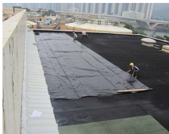
妥善鋪設、保護和維修屋頂或平台的防水層
