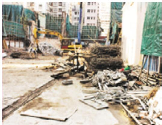
應清楚訂明有關物料及廢料的運送安排。必須注意在過程中不可令任何樓宇結構或裝置，如電梯負荷過重，否則可能引致倒塌。若有關工程需要使用客用電梯時，應先在電梯內妥為鋪上保護層。使用電梯時亦須在合資格人員監督下進行，避免超載。
