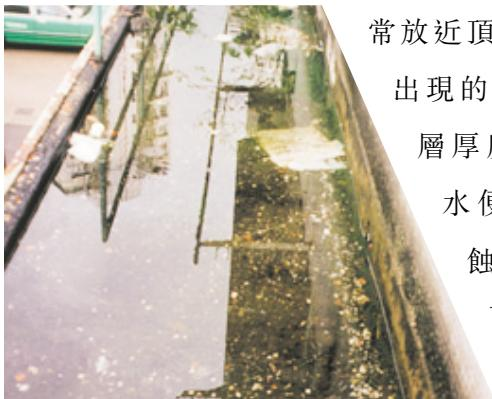
常放近頂部，而該處正是裂縫經常先出現的地方，因此，一旦頂部防水層厚度不足，或因裂縫而撕裂，水便容易從外滲入，令鋼筋銹蝕。銹蝕會減少鋼筋的有效橫切面面積，減低其負荷能力，引發突然倒塌的意外。
