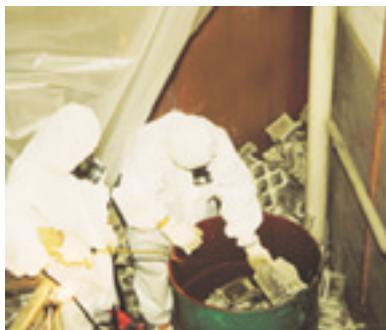
已被拆除的含石棉物料不能被當作普通建築廢料來處理。它們應在一個受監控的環境下分開處理、收集並存放在認可的容器內，然後才埋藏於指定的政府堆填區內。
