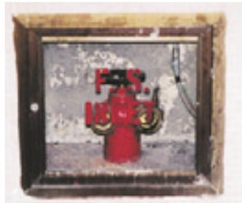
在每個工程階段，消防裝置均應操作良好。如果進行樓宇公用部份的大型工程，應先檢查現有的消防裝置，如滅火喉、喉轆、警鐘、自動灑水系統等，確保這些裝置操作正常，方可展開工程。
