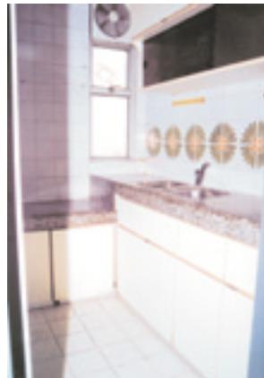
較常見的漏水成因是浴缸、洗手盆、洗滌盆周邊的防漏膠破損，或地台的防水系統出現問題。防漏膠的問題比較容易解決，只需重敷相同的物料便成。但若使用廚房廁所時有經常弄濕地面的習慣，那防水系統的功能便會受到嚴峻的考驗。如果漏水是因為經常有水濺到地面上，而防水層又有破損的話，建議不要進行局部修葺，而應重新鋪設整個防水層。
