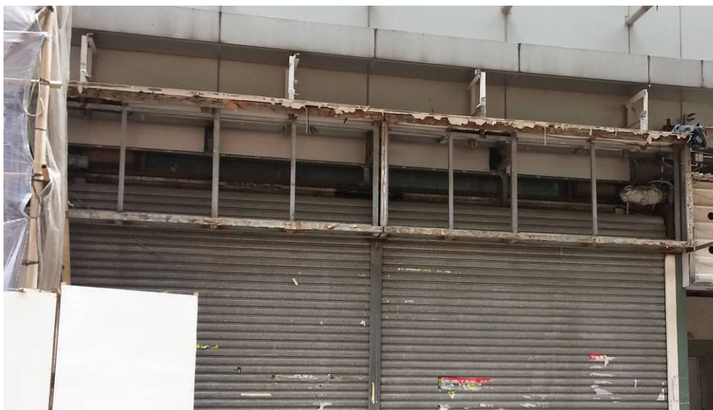
照片3: 招牌的支撐點B2 (支撐點A1-A6, B1, B3-B6皆類同)
