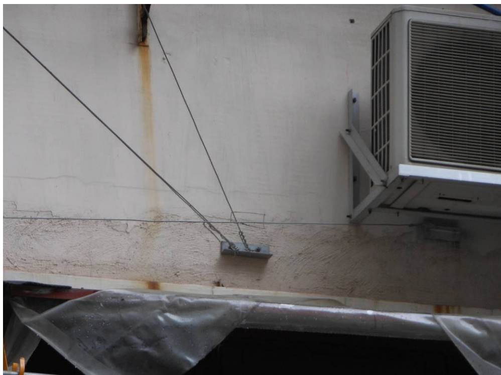
照片5: 招牌的右方的錨固點B2及B3
