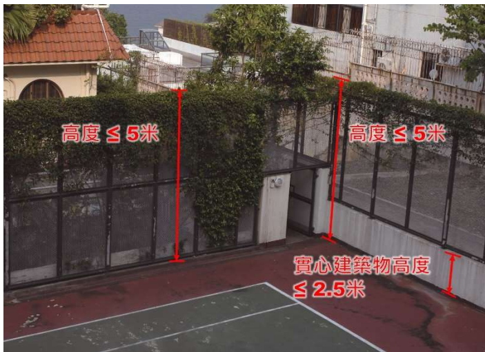
第 3.5 項 拆除地面上的室外網欄
