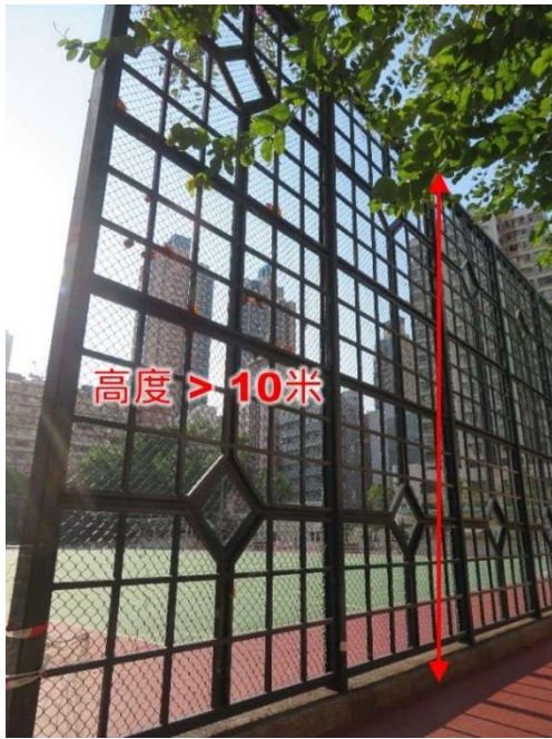
第 1.10 項 拆除地面上的室外網欄
