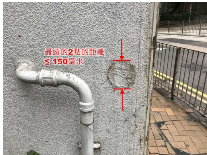
第 3.46 項 在非承重鋼筋混凝土外牆／用磚建造的非承重外牆復原洞口
