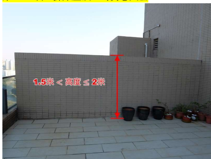
第 2.64 項 拆除屋頂上的實心圍牆
