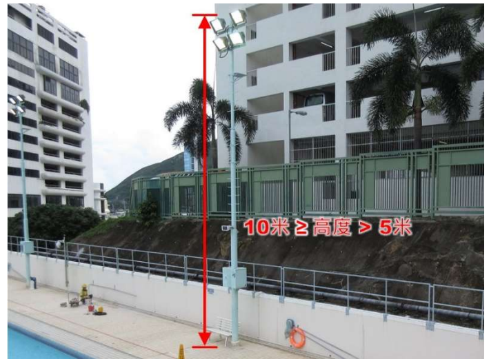
第 2.66 項 拆除地面上的室外支柱
