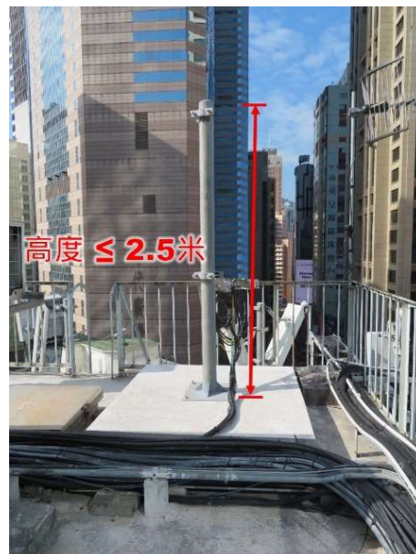
第 3.60 項 修葺屋頂上的支柱
