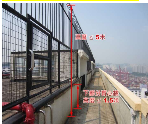
第 2.62 項 修葺屋頂上的網欄／金屬欄杆
