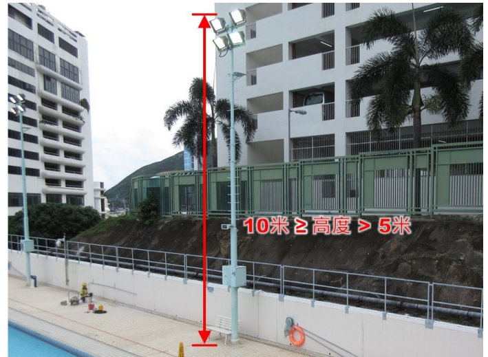
第 2.59 項 修葺地面上的室外支柱
