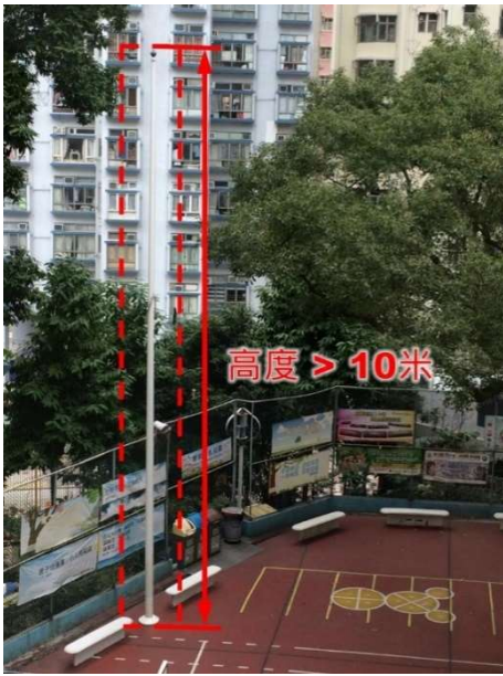
第 1.10 項 拆除地面上的室外支柱
