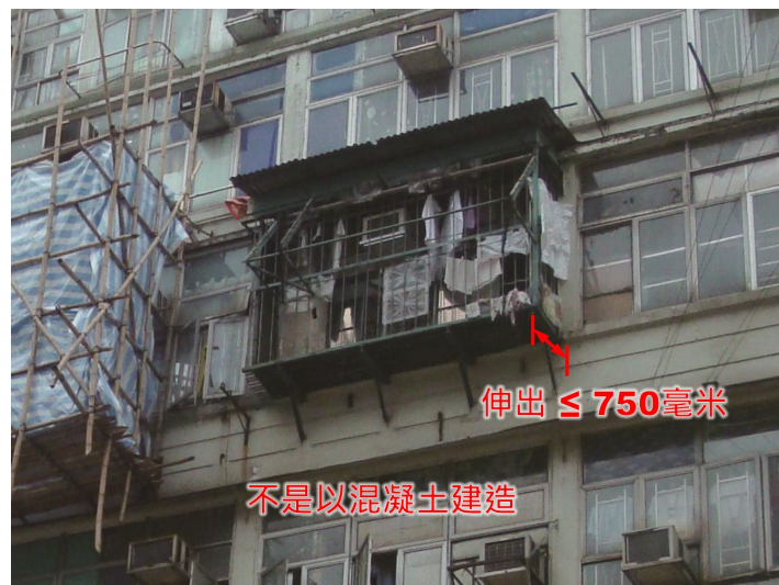
第 3.26 項 拆除自外牆伸出的架
