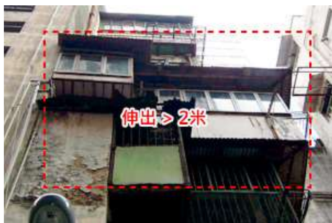
第 1.30 項 拆除違例構築物
