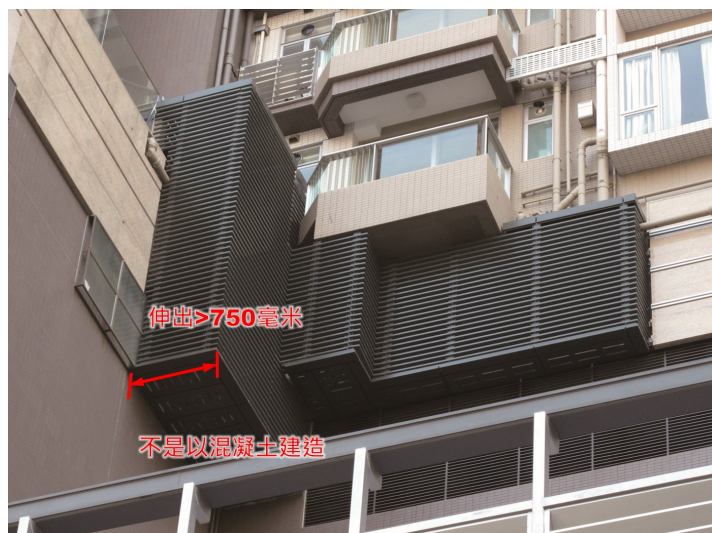
第 2.31 項 拆除自外牆伸出的建築上的伸出物
