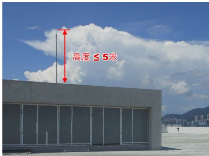
第 1.54 項 屋頂上的支柱
