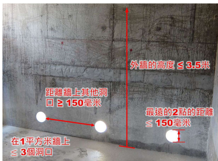
第 3.45 項 在非承重鋼筋混凝土外牆／用磚建造的非承重外牆開鑿洞口
