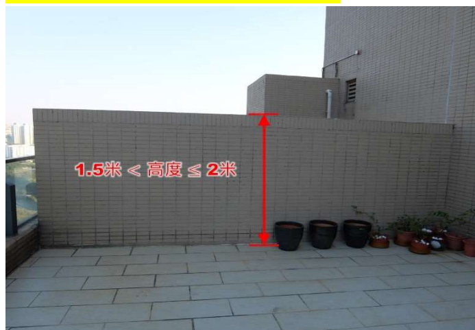
第 2.61 項 修葺屋頂上的實心圍牆
