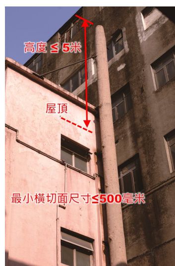
第 2.37 項 拆除煙囪
