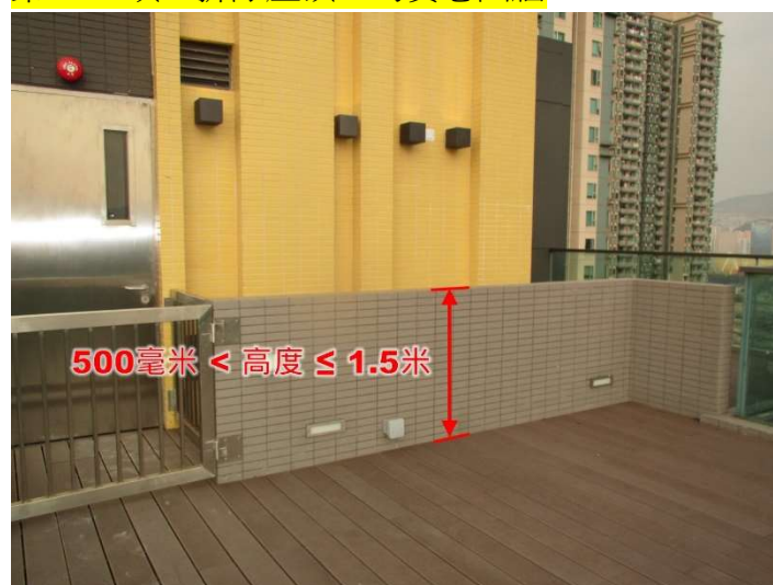
第 3.64 項 拆除屋頂上的實心圍牆
