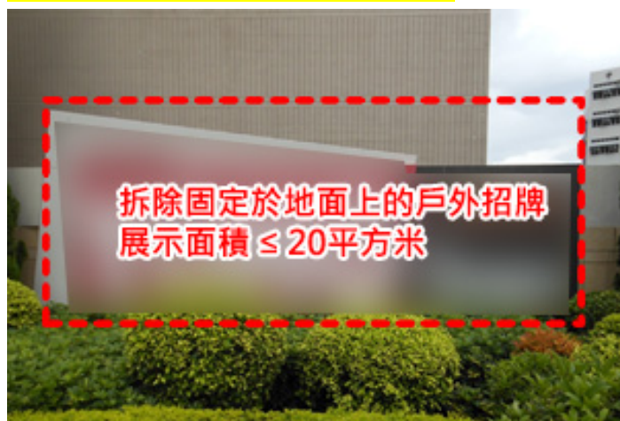
第 2.25 項 拆除地面上的戶外招牌
