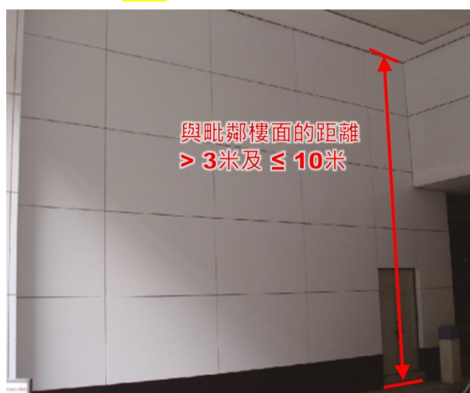
第 2.33 項 豎設、修葺或拆除建築物內牆壁上的鑲板
