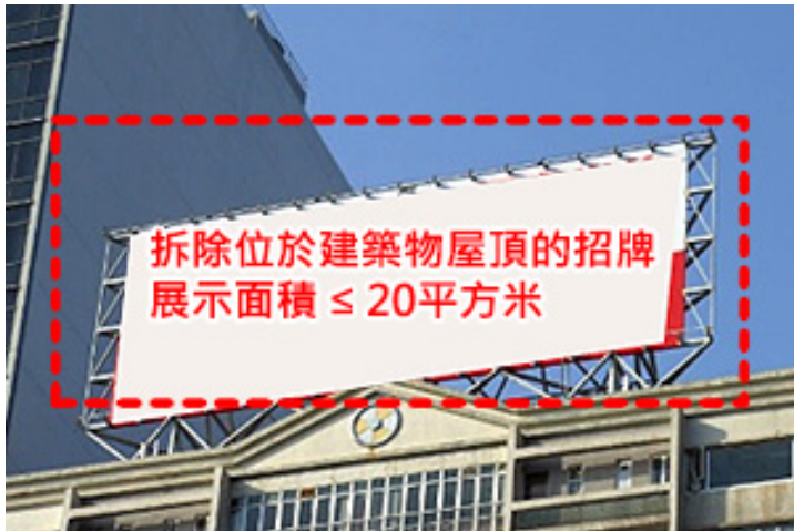
第 2.25 項 拆除位於屋頂的招牌
