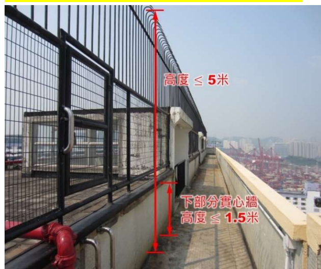
第 2.65 項 拆除屋頂上的網欄／金屬欄杆
