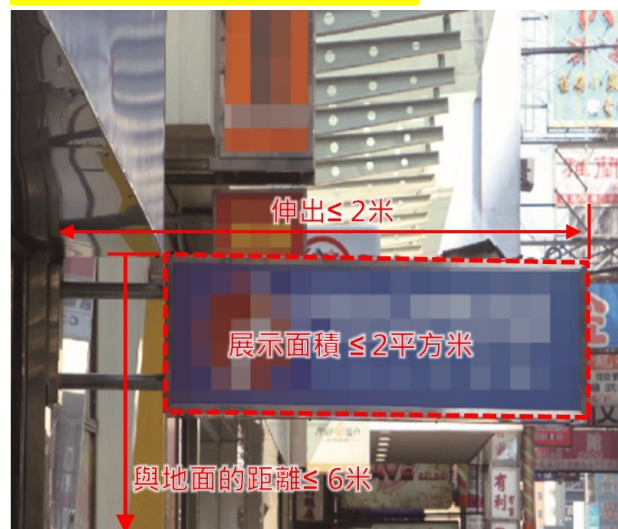
第 3.18 項 拆除伸出式招牌
