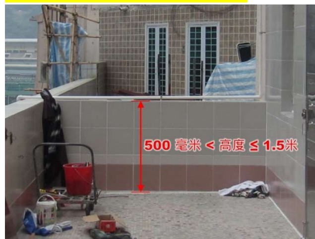
第 3.61 項 修葺屋頂上的實心圍牆
