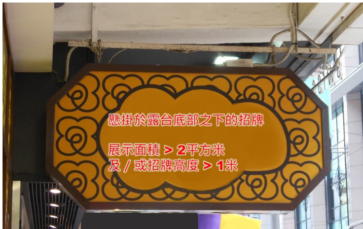
第 2.27 項 拆除懸掛於露台底部之下的招牌
