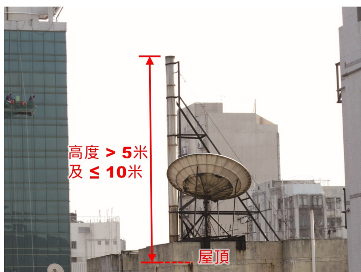
第 1.37 項 拆除煙囪
