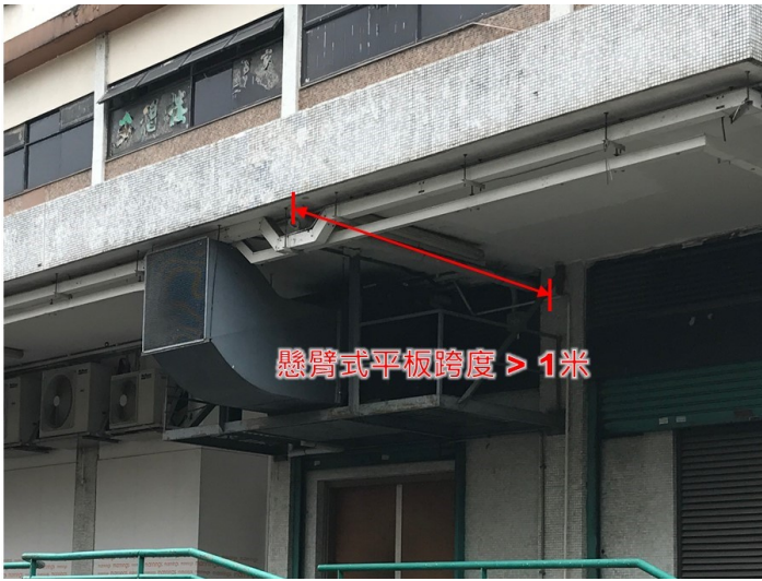
第 1.5 項 拆除位於懸臂式平板下的通風管道或相關的承托支架
