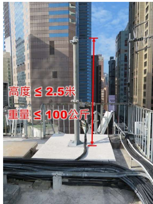
第 2.54 項 屋頂上的支柱
