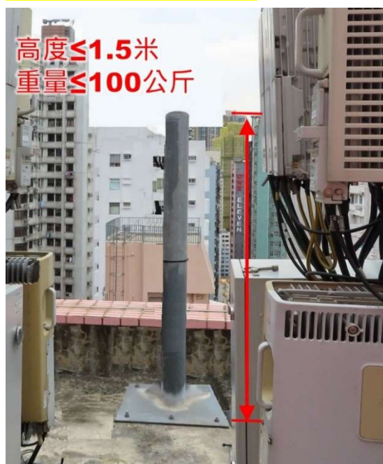
第 3.54 項 屋頂上的支柱
