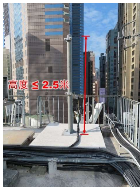
第 3.63 項 拆除屋頂上的支柱
