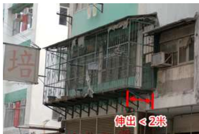
第 2.32 項 拆除違例構築物
