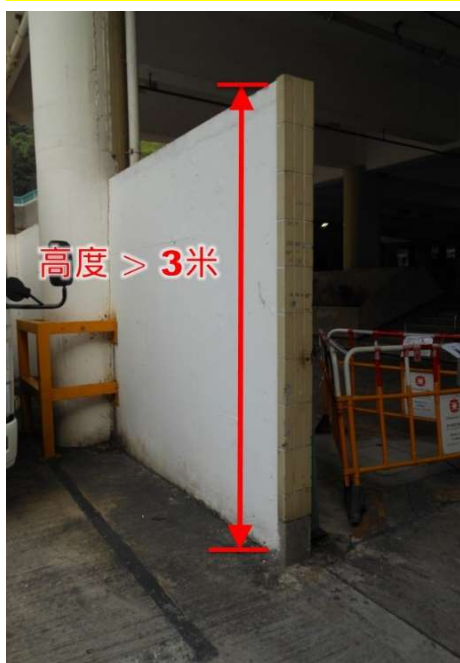
第 1.9 項 拆除地面上的實心圍牆
