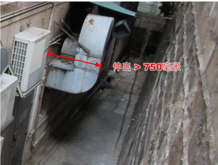
第 2.31 項 拆除自外牆伸出的通風管道或相關的承托支架
