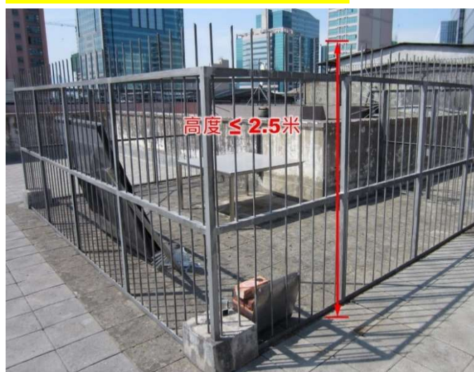
第 3.62 項 修葺屋頂上的金屬欄杆
