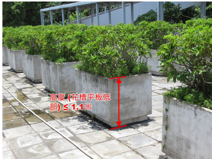
第 3.52 項 修葺或拆除屋頂上的花槽
