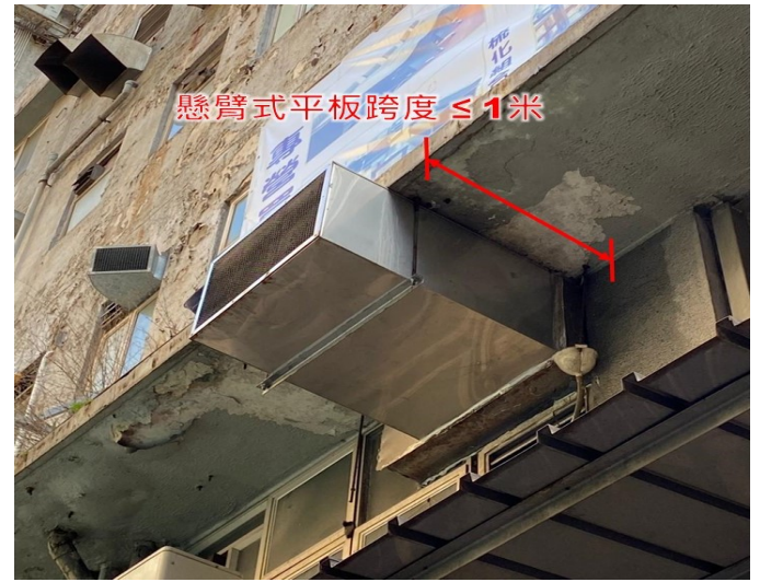
第 2.2 項 拆除位於懸臂式平板下的通風管道或相關的承托支架
