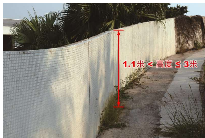
第 3.4 項 拆除地面上的實心圍牆
