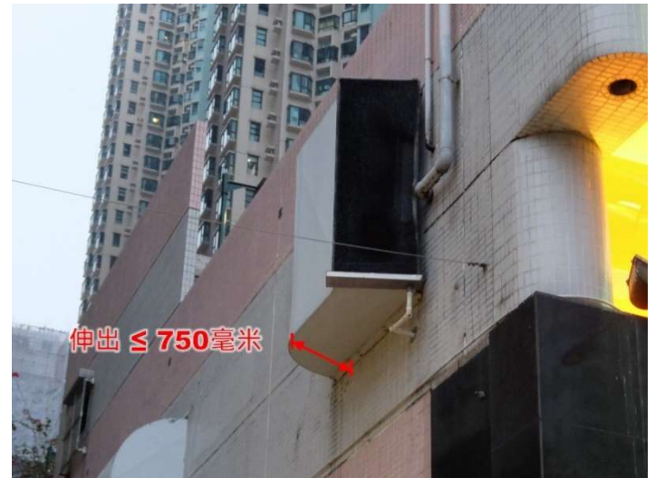
第 3.49 項 拆除自外牆伸出的通風管道或相關的承托支架
