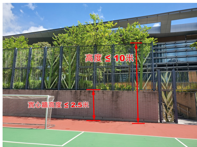
第 1.59 項 於地面上的實心圍牆頂部豎設網欄
