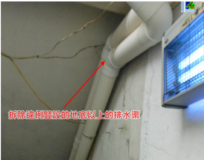
第 3.24 項 拆除違例豎設的地底以上的排水渠
