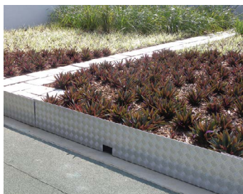
綠化設施設有排水口以排放多餘水份
