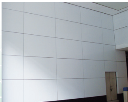
以金屬暗銷及嵌固件固定於建築物內牆壁上的鑲板
