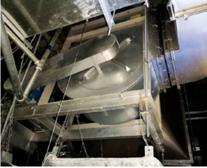
機械通風裝置的承托支架
