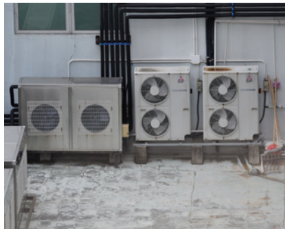
空調機的支承構築物
