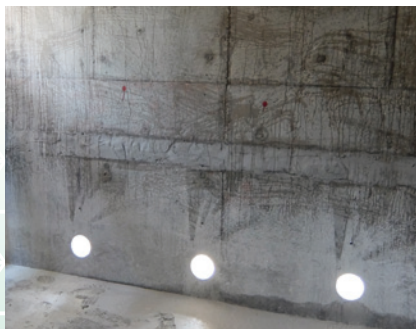
在外牆開鑿洞口
