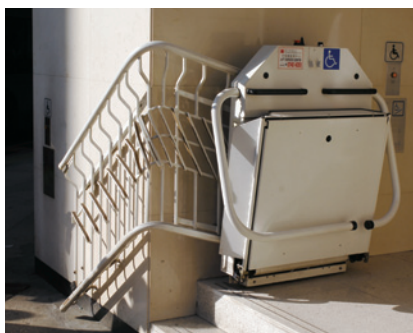
樓梯升降機或升降平台 相關建築工程
