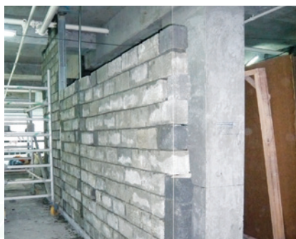
用磚建造的非承重牆
