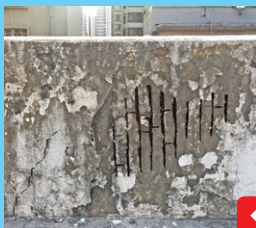
裂痕 / 鋼筋外露
