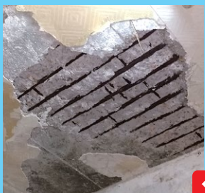
石屎剝落 / 鋼筋外露
