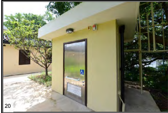
New accessible toilet
